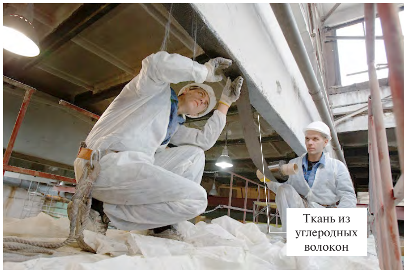
Рисунок 1.11 – Общий вид усиливаемой конструкции холстами из углеродных волокон на объекте промышленного предприятия
