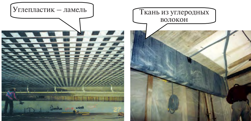
Рисунок 1.12 – Железобетонные конструкции промышленных зданий, усиленные композитными материалами на основании углеродного волокна
