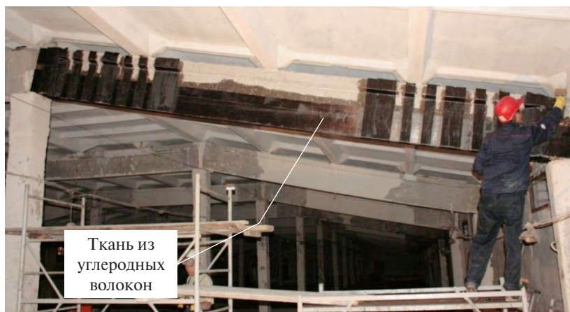
Рисунок 1.10 – Железобетонная балка перекрытия промышленного каркасного здания, усиленная холстом из углеродных волокон
