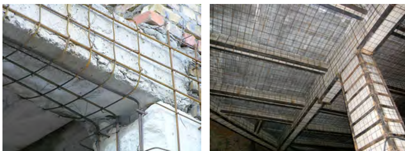
Рисунок 1.5 – Внешнее металлическое армирование восстанавливаемого горнотехнического промышленного здания
