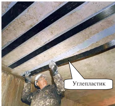
Рисунок 1.13 – Конструкция усиления железобетонной плиты перекрытия
