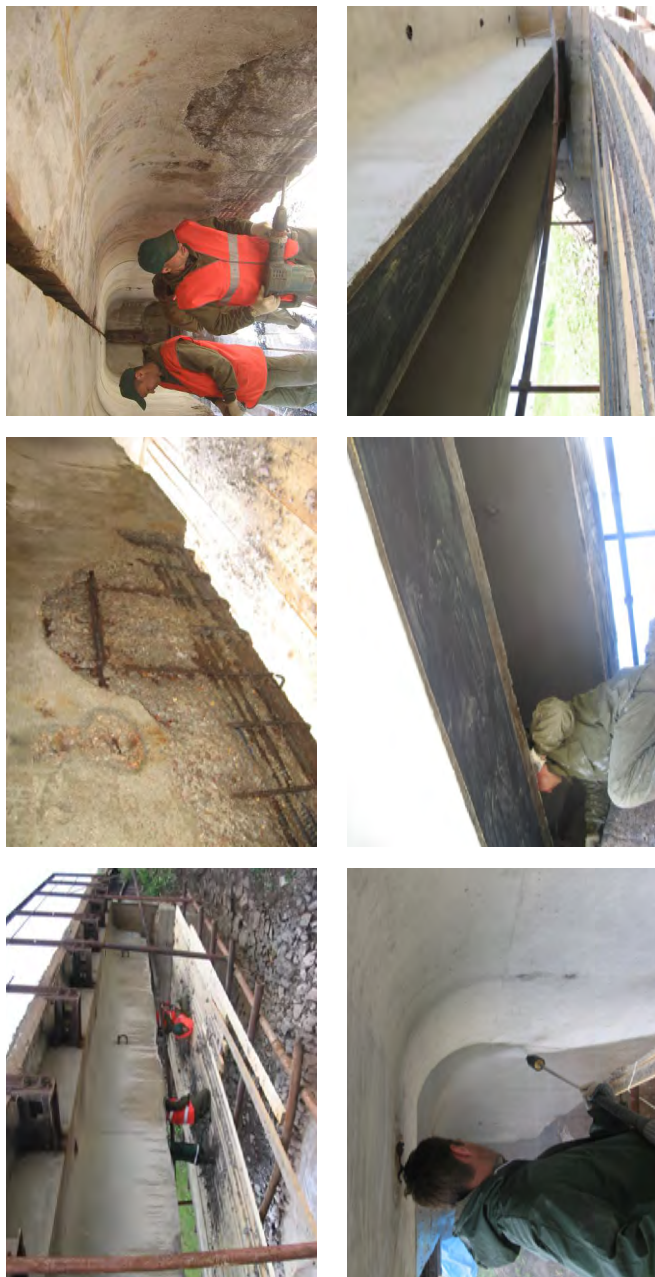
Рисунок 7.3 — Технология ремонта и усиления композитными материалами однопролетного железобетонного моста, расположенного на пути общего пользования в г. Соликамске
